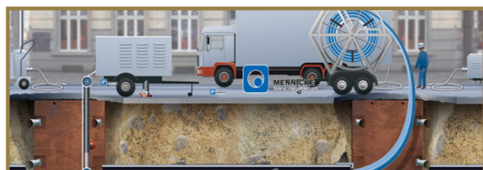
Réhabilitation en close Fit : Réseaux AEP, ASSAINISSEMENT
