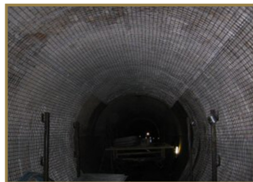
Ferrailage avec nappe de treillis soudés galvanisés
