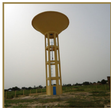
Construction de château d'eau
